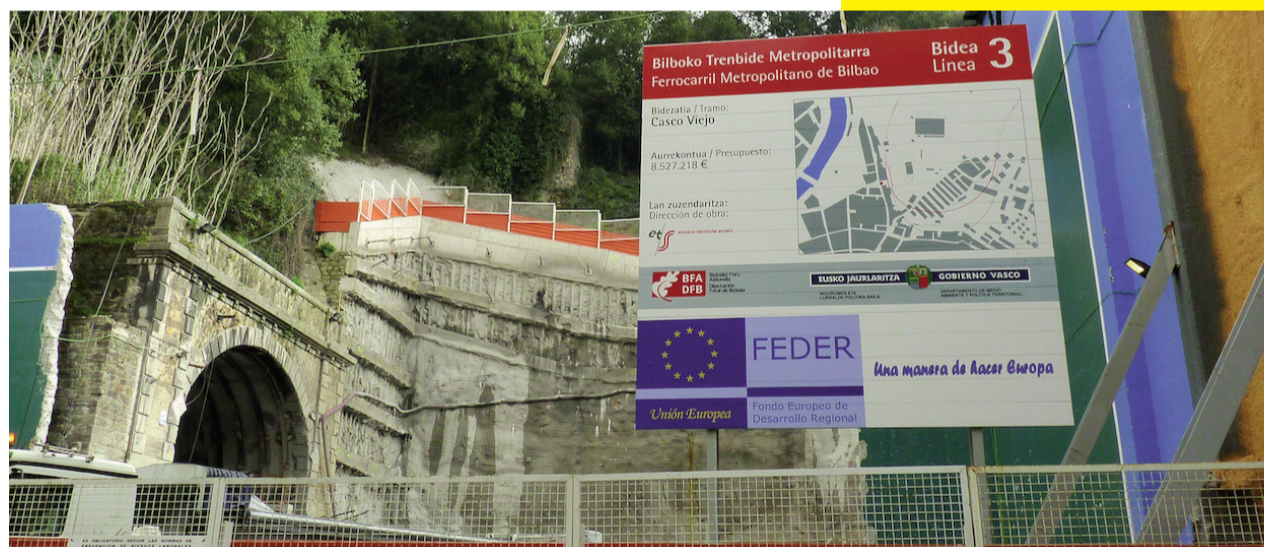
La Línea 3 del Metro de Bilbao es uno de los proyectos que cuentan con financiación comunitaria
